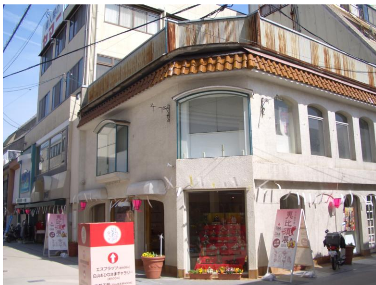
(コミュニティカフェ出店候補の建物)
