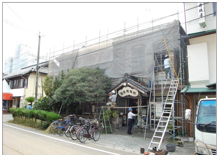
(松尾写真館・古いペンキの除去作業、新馬場)
