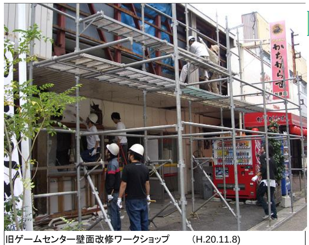
旧ゲームセンター壁面改修ワークショップ (H.20.11.8)
